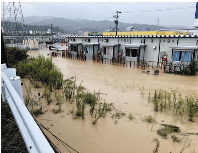
河原田川が氾濫し浸水した仮設住宅＝21日午後 3時11分、石川県輪島市宅田町で
